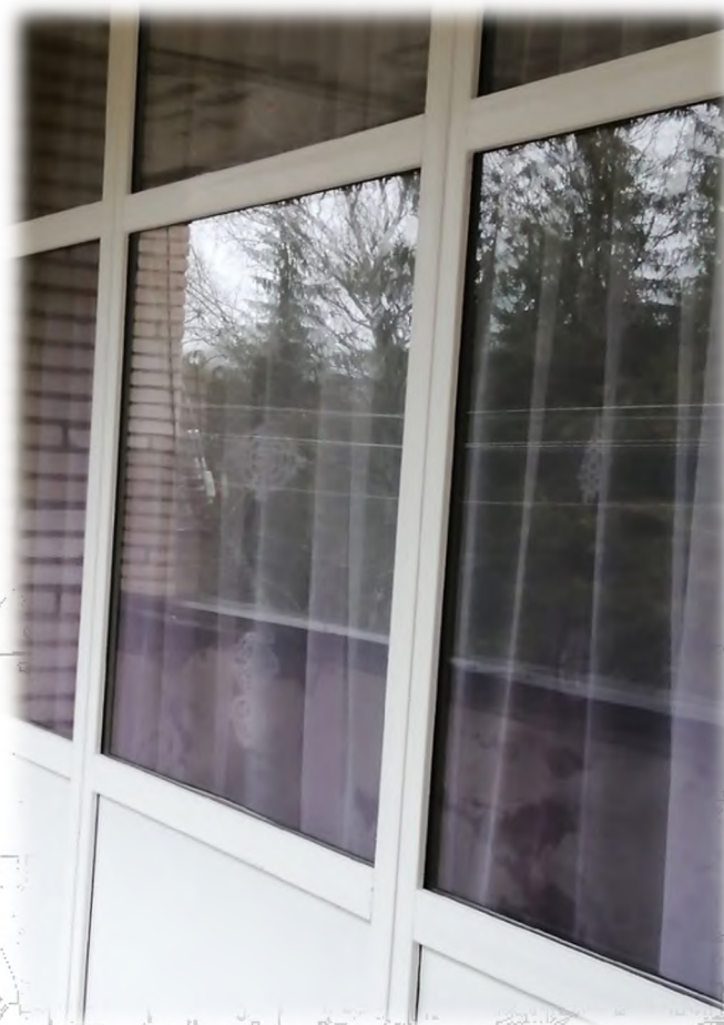
Дом культуры д. Ручьи (ремонт оконных конструкций)
