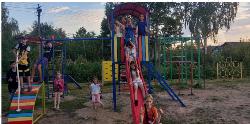
Установка игрового оборудования д. Новое Рахино
